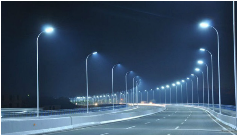
Photo n° 10 : éclairage d'une voie rapide
