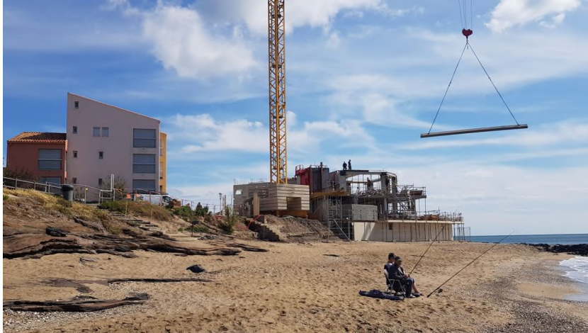
Photo n°9 : construction d'un immeuble en front de mer
