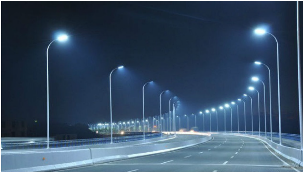
Photo n° 10 : éclairage d'une voie rapide
