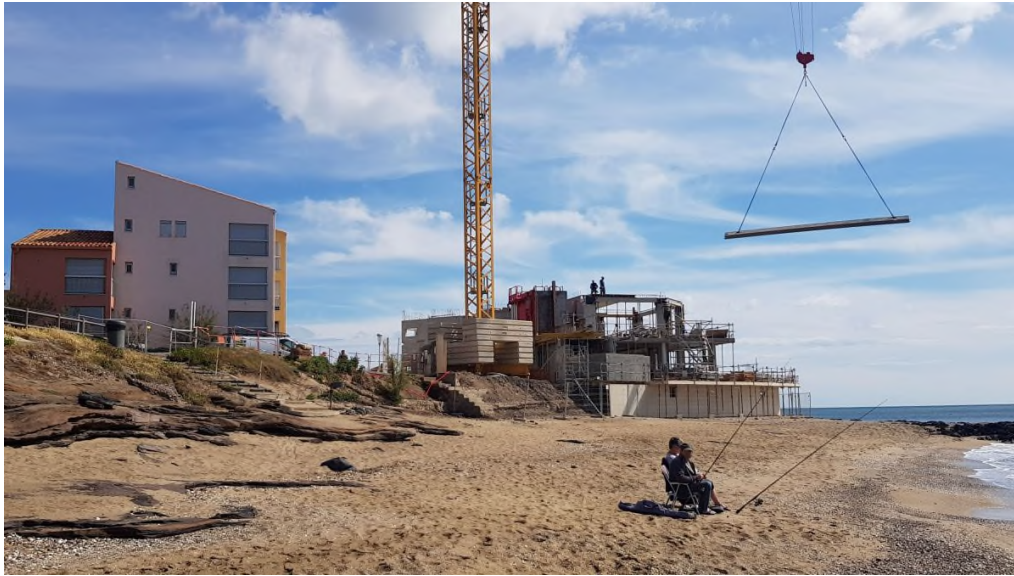
Photo n°9 : construction d'un immeuble en front de mer
